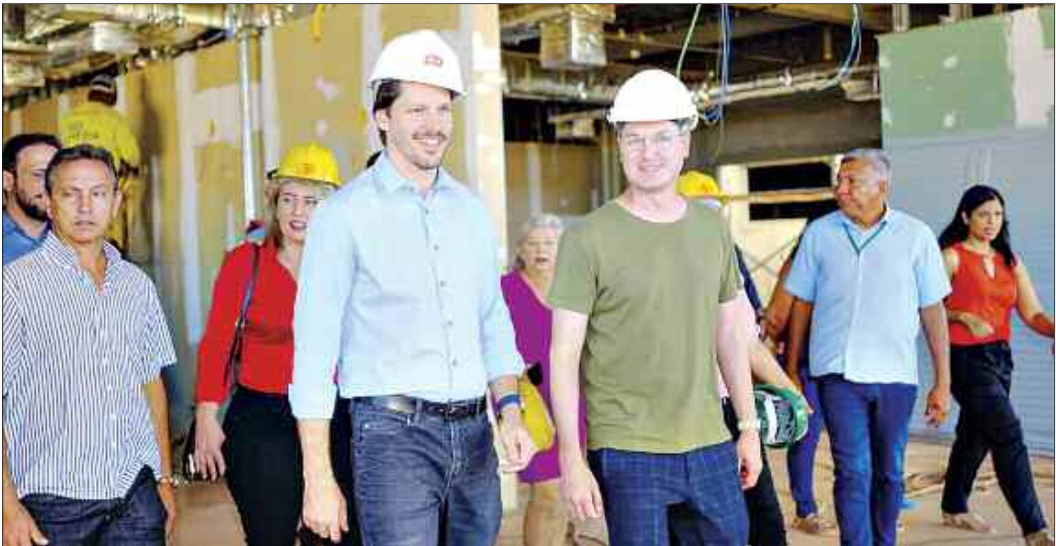
Governador em exercício Daniel Vilela visita a estrutura do Hospital Estadual de Águas Lindas, que será entregue ainda este ano
