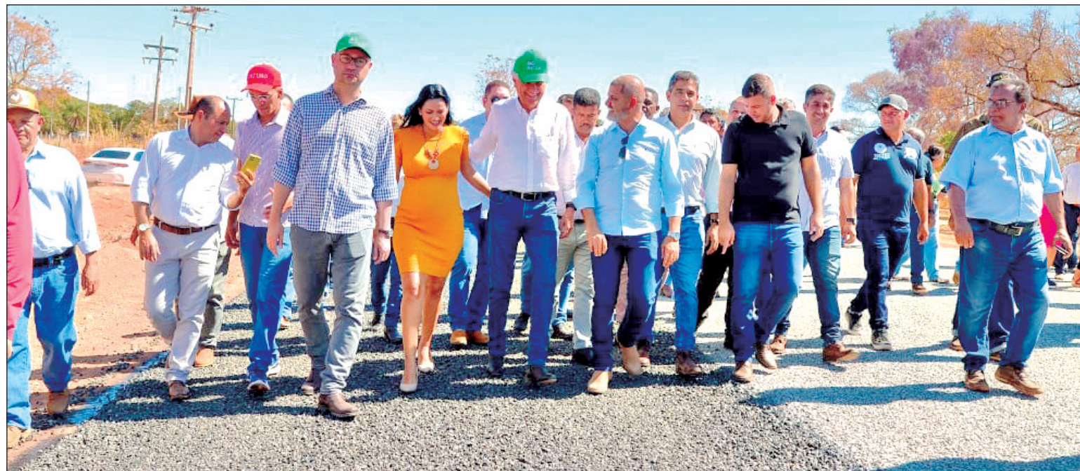
Governador Ronaldo Caiado vistoria pavimentação da GO-156, obra será concluída em setembro
