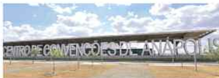
Centro de Convenções de Anápolis também foi abandonado em 2018, após receber R$ 154 milhões para obras.
