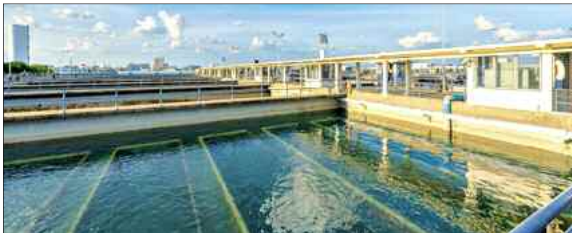
Sistema de Abastecimento de Água Mauro Borges faz parte da estratégia de universalização do saneamento básico
