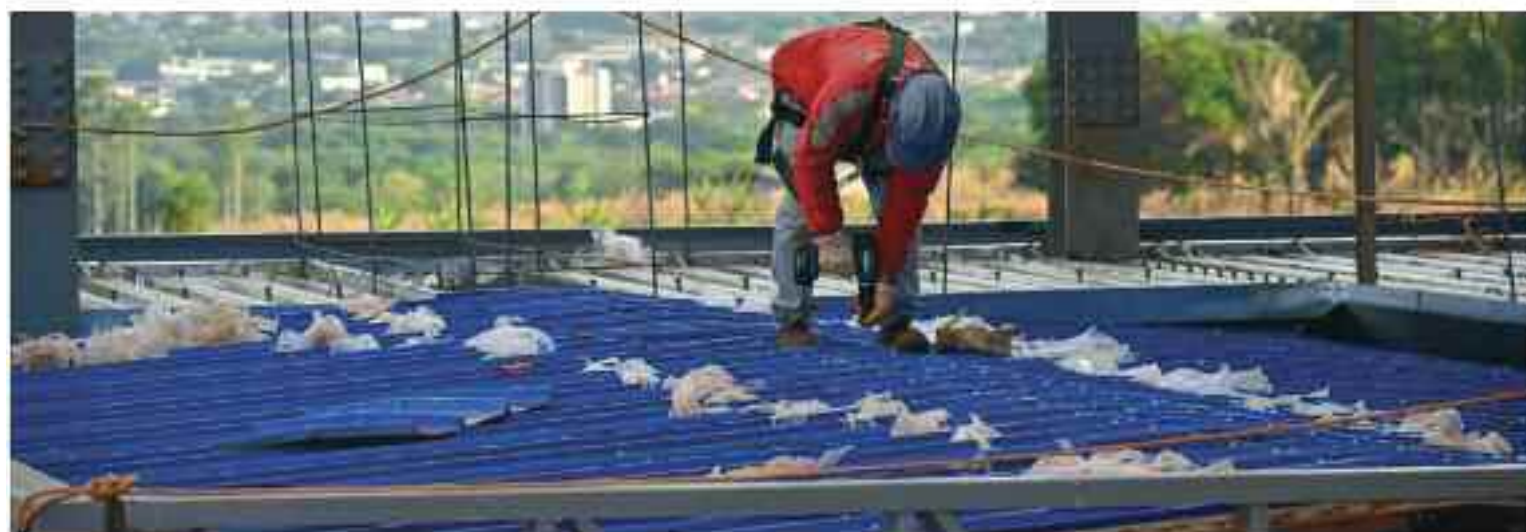
Fundações, lajes e armações da ala infantil do Complexo Oncológico de Referência de Goiás (CORA) foram finalizadas, representando 40% do total da obra.
