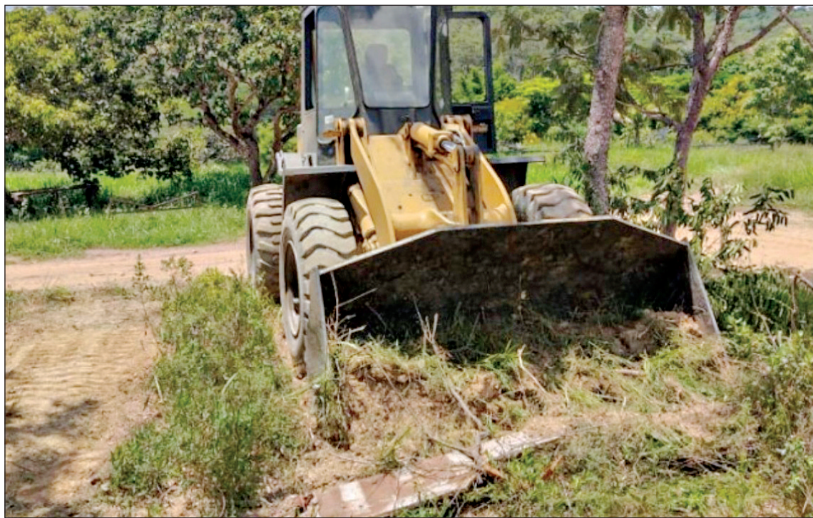
Flagrante de desmatamento ilegal em Luziânia, que atingiu área de preservação permanente
