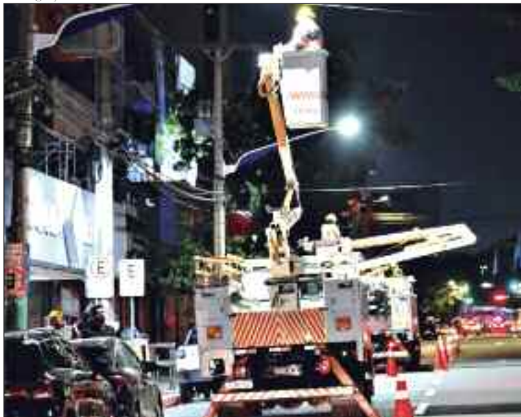
Depois de finalizar troca de lâmpadas no Centro, Prefeitura de Goiânia inicia trabalho na Região Noroeste
