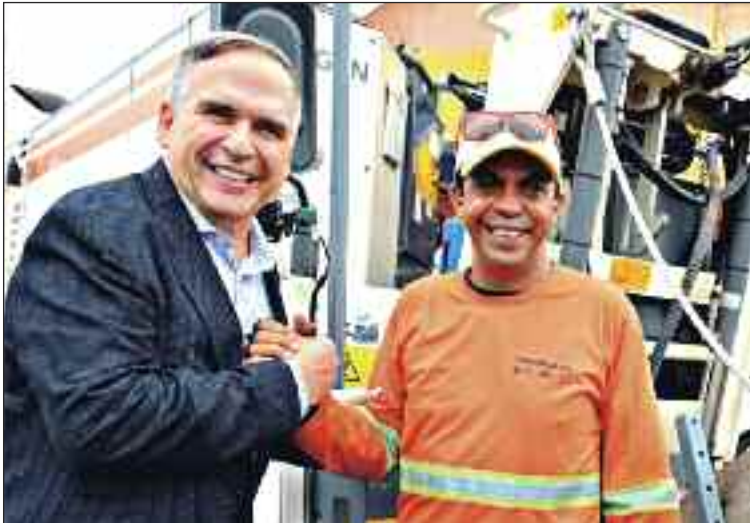
Em obra no Jardim Novo Mundo, prefeito cumprimenta trabalhador do Consórcio CFJ; custa da obra é de R$ 10,3 milhões
