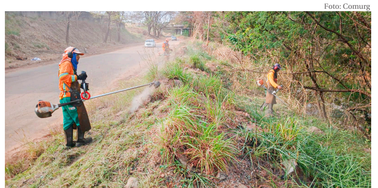
Serviços realizados às margens do Córrego Cascavel
